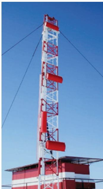
Антенная система глиссадного радиомаяка
