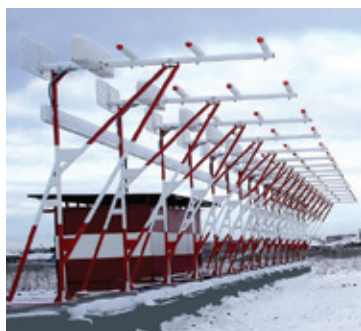
Антенная система курсового радиомаяка
